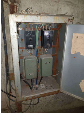
Esamas ventiliatorių valdymo skydas-demontuoti
